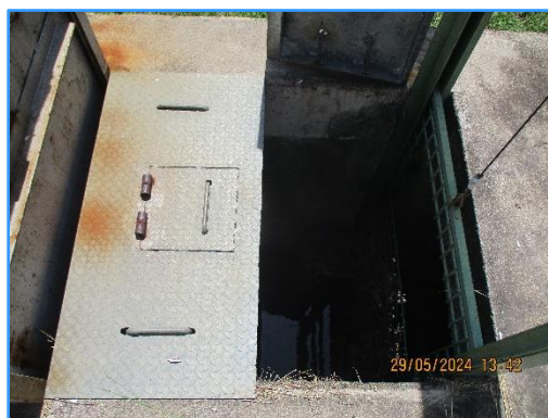
ภาพที่ 2.25 บ่อดักตะกอนและตะแกรงดักขยะมูลฝอย
