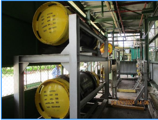
ภาพที่ 2.41 ถังเก็บแอมโมเนียทรงกระบอกแบบปิด
