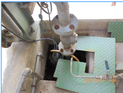
ภาพที่ 2.47 ระบบสูบน้ำที่รั่วไหลในพื้นที่ปฏิบัติงานเกี่ยวกับแอมโมเนีย
