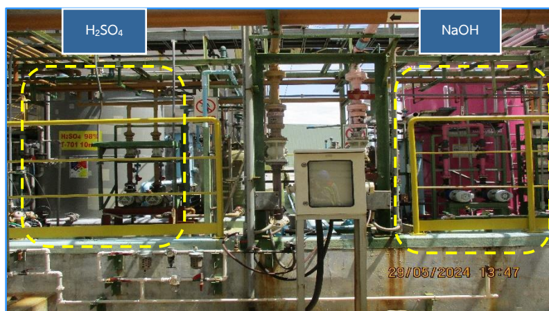
ภาพที่ 2.40 ถังจัดเก็บสารเคมี NaOH และ H 2 SO 4
