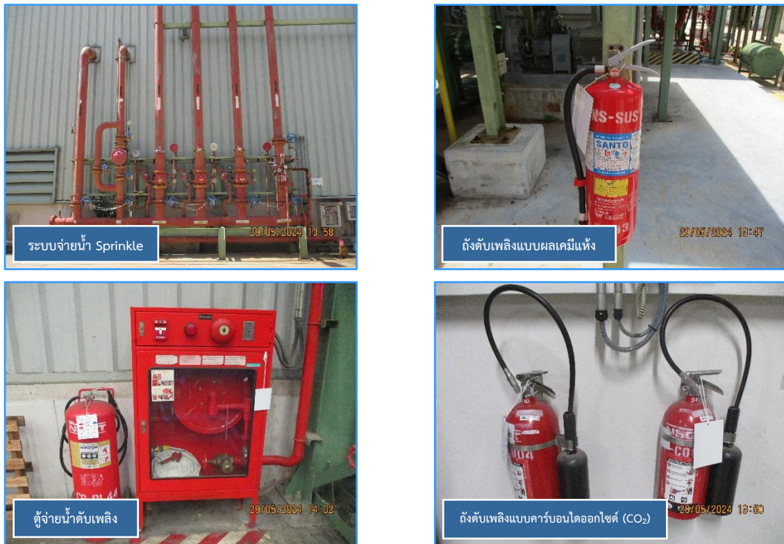
ภาพที่ 2.38 ระบบดับเพลิงภายในพื้นที่โครงการฯ
