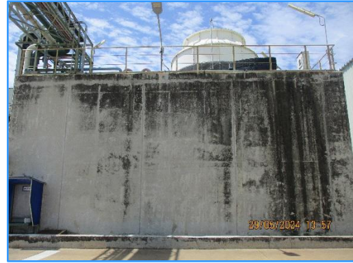
ภาพที่ 2.18 บ่อรองรับน้ำทิ้งที่ผ่านการบำบัดแล้ว (Buffer pit B) ขนาด 3,325 ลูกบาศก์เมตร
