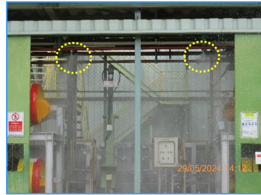
ภาพที่ 2.50 ระบบสเปรย์น้ำบริเวณถังแอมโมเนีย
