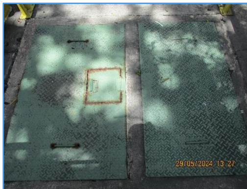
ภาพที่ 2.19 บ่อตรวจสอบคุณภาพน้ำ (Inspection pit)
