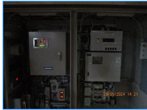
ภาพที่ 2.4 ระบบตรวจวัด NO x จากปล่องแบบต่อเนื่อง (Continuous Emission Monitoring System : CEMs)
