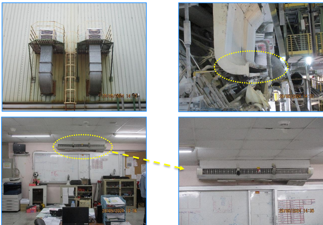
ภาพที่ 2.8 ท่อลมเย็นระบายอากาศและห้องควบคุมที่มีระบบปรับอากาศ
