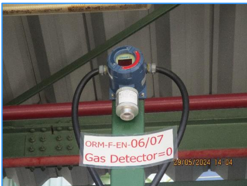
ภาพที่ 2.43 Gas detector บริเวณที่จัดเก็บ แอมโมเนีย
