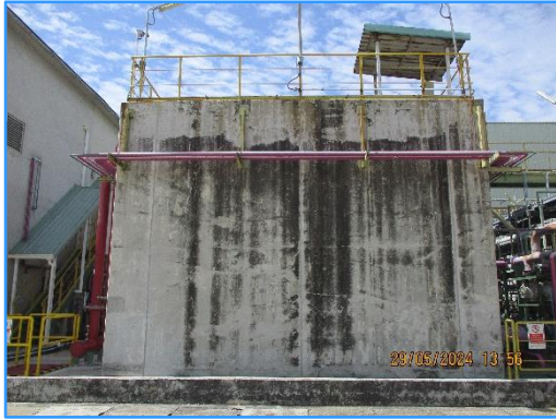
ภาพที่ 2.17 บ่อรองรับน้ำทิ้งที่ผ่านการบำบัดแล้ว (Buffer pit A) ขนาด 175 ลูกบาศก์เมตร
