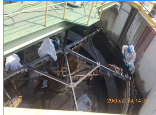
ภาพที่ 2.22 การขุดลอกตะกอนบริเวณบ่อพักน้ำทิ้ง ของโครงการฯ
