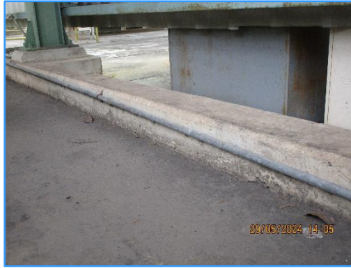
ภาพที่ 2.45 เชื้อนป้องกันการหกรั่วไหลรอบพื้นที่จัดเก็บถังแอมโมเนีย
