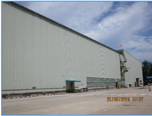
ภาพที่ 2.9 การออกแบบอาคารเป็นอาคารปิด เพื่อป้องกันเสียงดังออกสู่ภายนอกโครงการฯ
