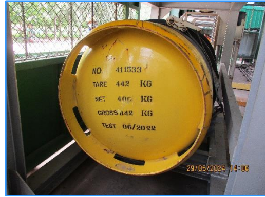
ภาพที่ 2.41 ถังเก็บแอมโมเนียทรงกระบอกแบบปิด
